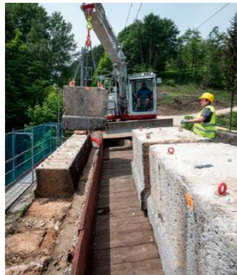
Abtragen der Brüstungsmauersteine auf den Viadukten. ÖBB/Wolff
